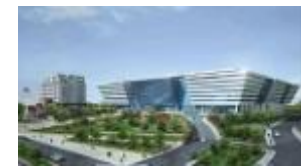
ระบบ CO-Generation ศูนย์ราชการกรุงเทพมหานคร
